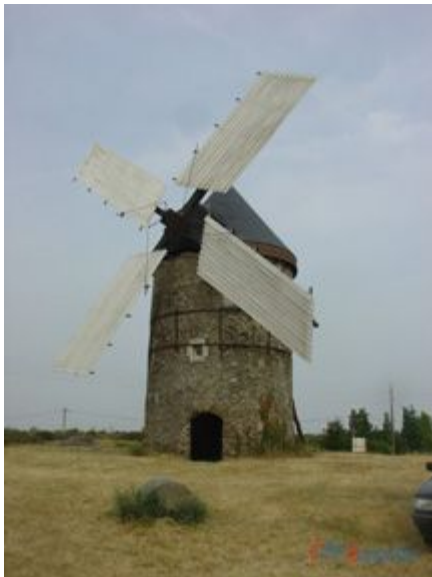
Le Moulin de la Roche à la Possonnière (Anjou), avec ses ailes à planches, système Berton, ouvertes. Photo courtoisie (Photo:Moulin 20-08-06- )
