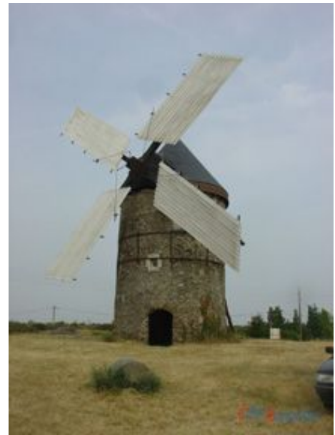
Le Moulin de la Roche à la Possonnière (Anjou), avec ses ailes à planches, système Berton, ouvertes. Photo courtoisie (Photo:Moulin 20-08-06- )
